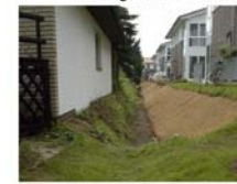
Bild 2: Entwässerungsmulde hinter Neubauten
