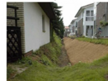
Bild 2: Entwässerungsmulde hinter Neubauten
